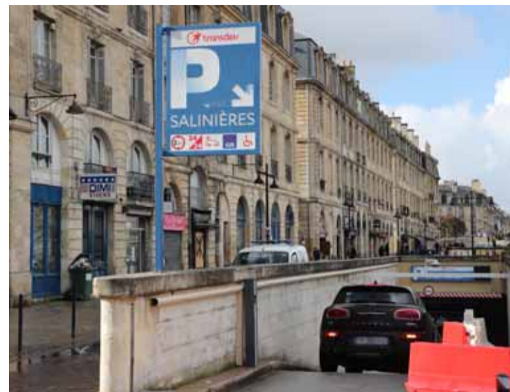
Le parking Salinières a rouvert après de longs mois de travaux suite à l'incendie. PHOTO FABIEN COTTEREAU
